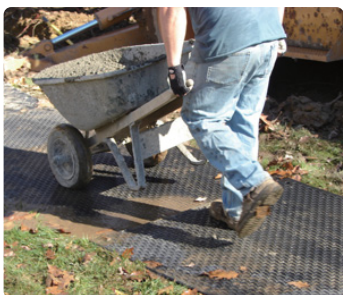
作業通路養生
