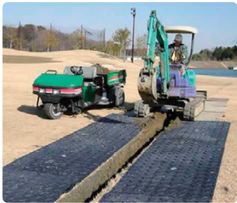
ゴルフ場整備
