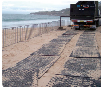
護岸工事(砂地養生)
